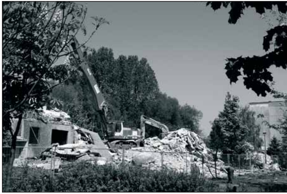
Abb. 5 Abriss am Lerchenberg
