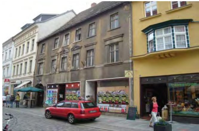
Altstadt: Unsanierete Wohnsituation
