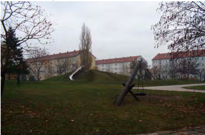
Wittenberg West: Sanierte Wohnblocks
