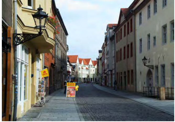
Alt- und Neubau in der Altstadt
