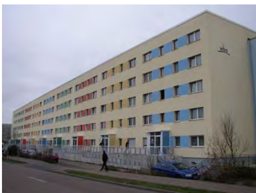
Seniorengerechte Modernisierung in der Dr.-Behring-Straße
