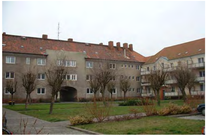
Piesteritz Süd: unsanierter Bestand
