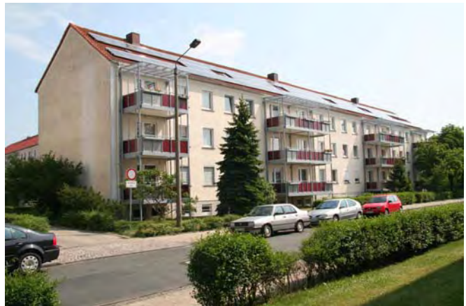
Wittenberg West: Wohnblock mit Solaranlagen
